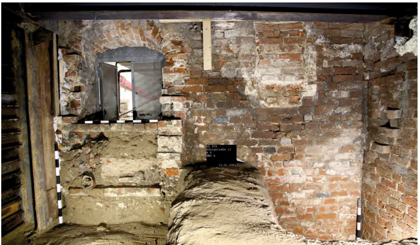
Abb. 9 Die Ostwand des Kellers mit einer zum Fenster umgebauten Treppe (links) und einem zugemauerten Fenster (rechts).
