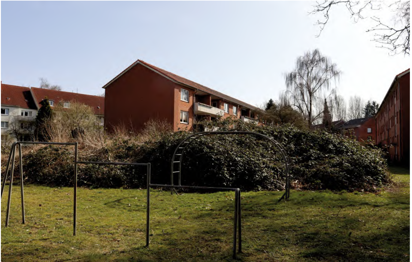
Abb. 45 Der Bunker in der Hebbelstraße ist noch unter einem bewachsenen Erdhügel verborgen.
