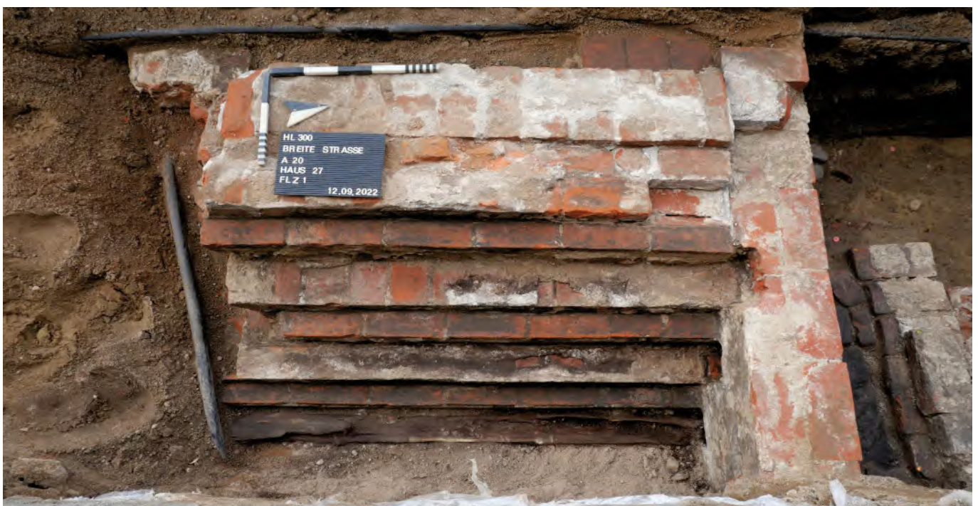
Abb. 8 Der Zugang von der Straße zum Keller des Hauses Breite Straße 27. Die unterste freigelegte Stufe besteht aus Holz.
