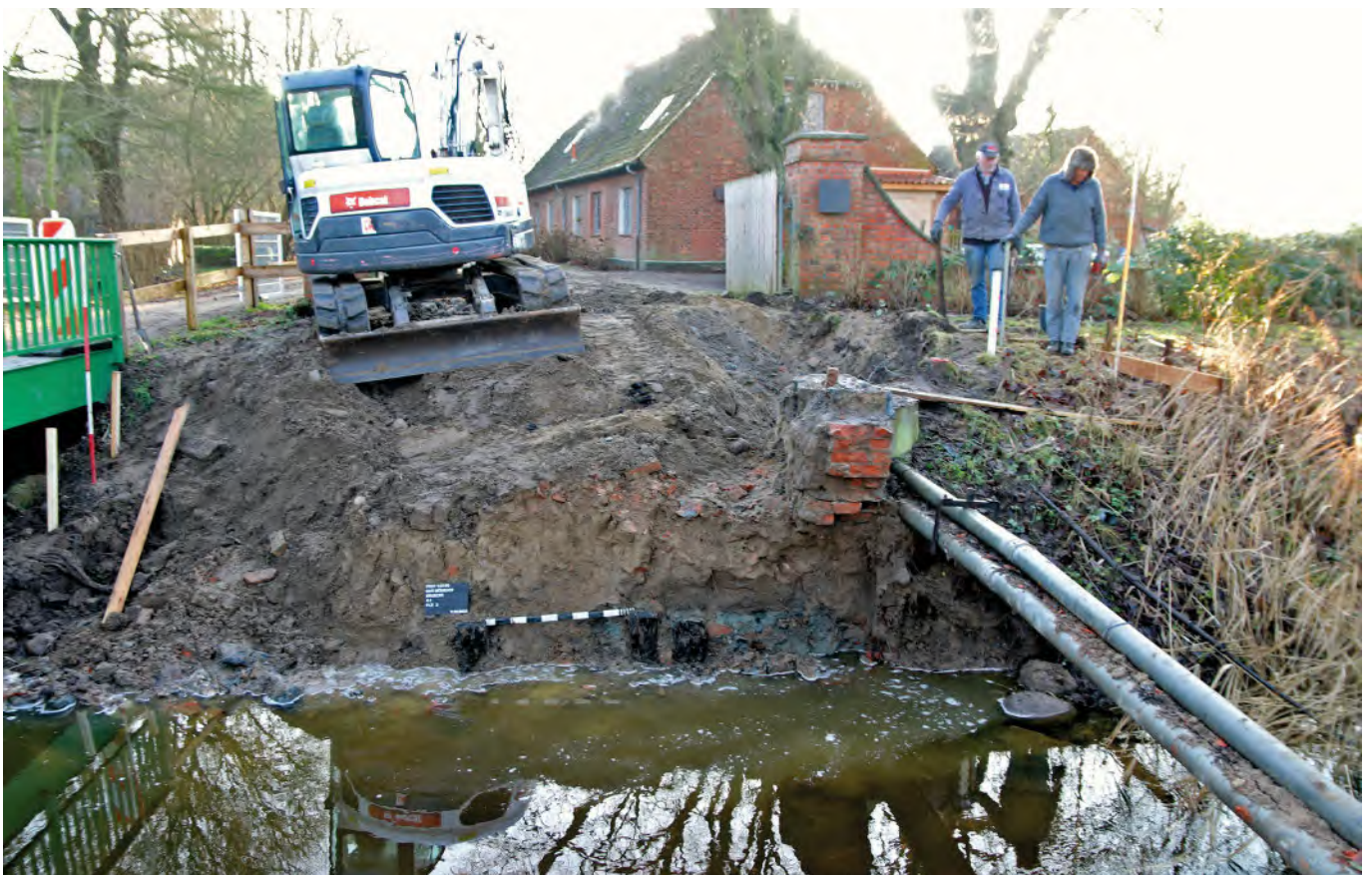
Abb. 4 Gem. Strecknitz, Fdst. 5.27.60. Drei noch in situ vorhandene Holzpfähle der Brückenkonstruktion auf der Südseite des Landgrabens.
