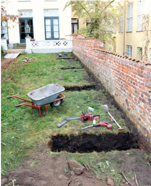
Abb. 11 Die Glintmauer zwischen Königstraße 9 und 11 mit abgetieften Schnitten für die Rückverankerung.
