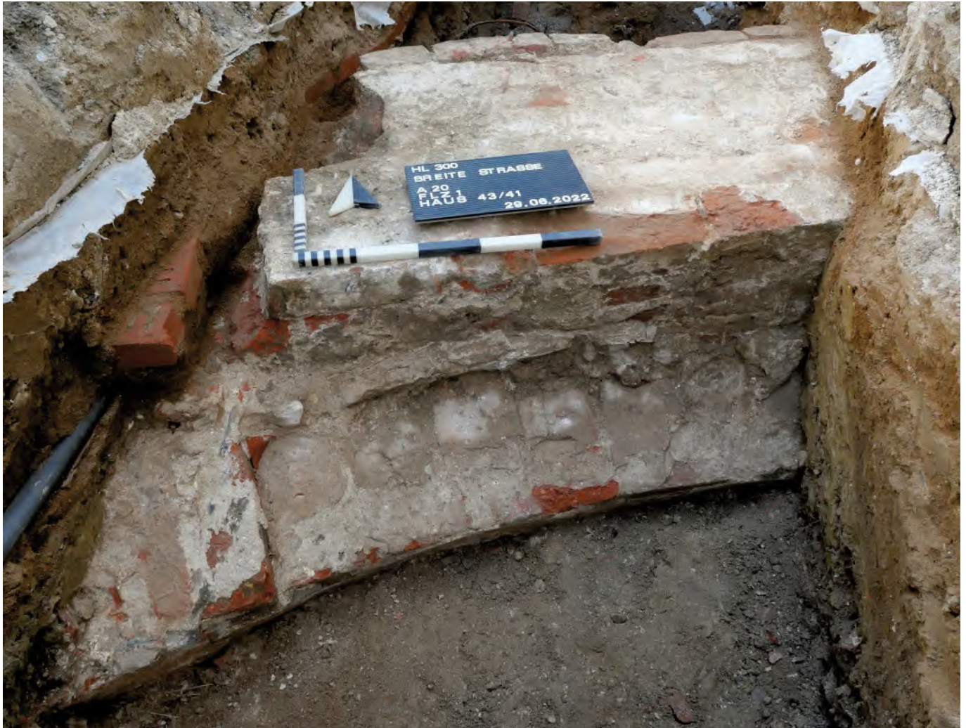
Abb. 7 Brandmauer zwischen den Häusern Breite Straße 41 und 43 mit Gewölbeansatz im Keller des Hauses 43.
