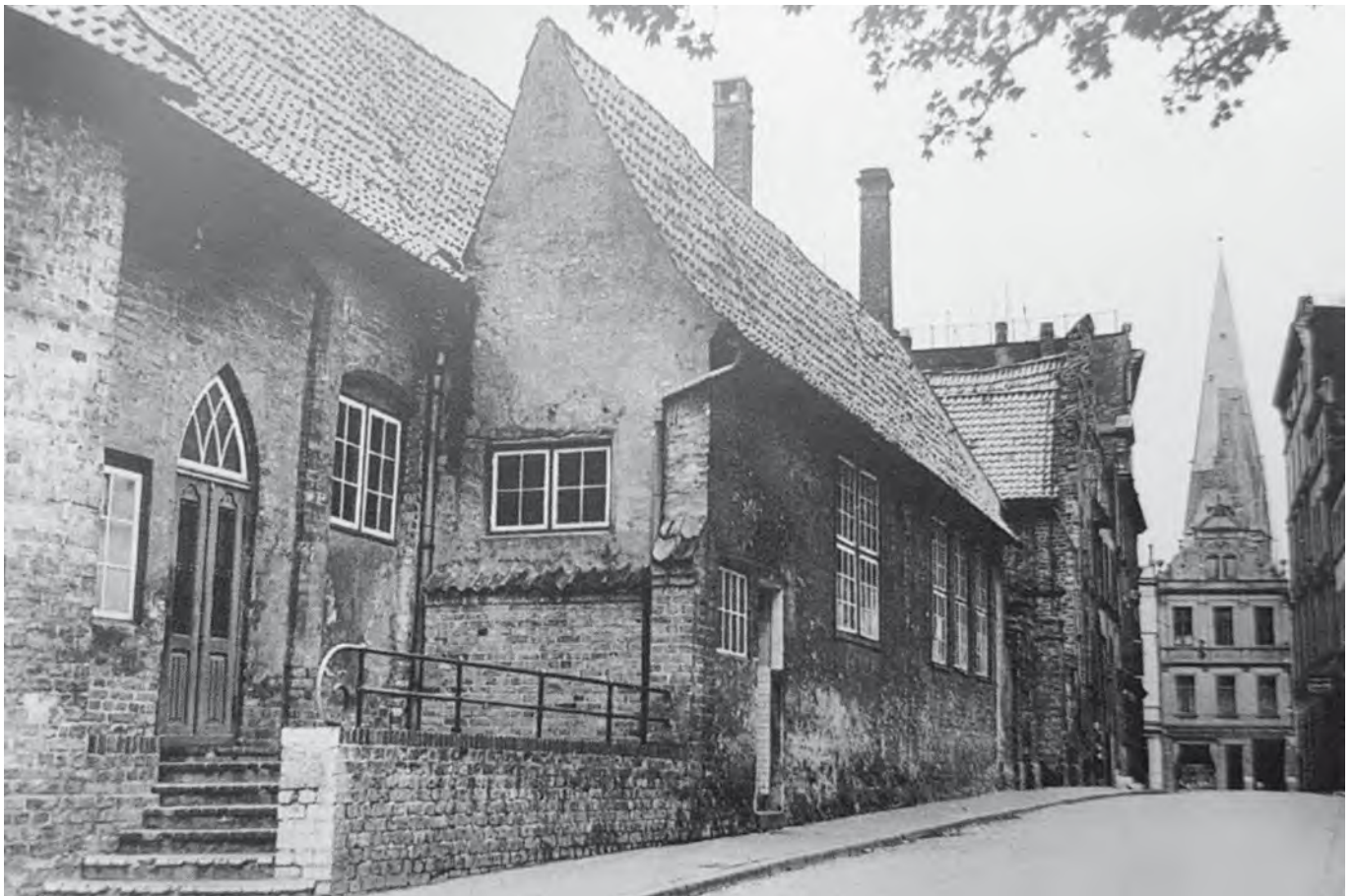
Abb. 1 Die Bebauung der Domherrenkurie an der Ecke Pferdemarkt/Kapitelstraße, Zustand vor 1942. Blick in die Kapitelstraße mit der Aegidienkirche im Hintergrund.
