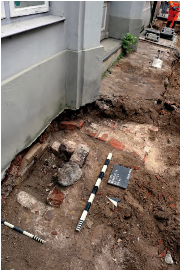
Abb. 2 Mengstraße 40a, Bildmitte: abgebrochenes Backsteinfundament einer großen Zugangstreppe zum Eingangsportal. Davor zugemauerte Fensteröffnung mit später vorgesetzter Lichtschachteinfassung.
