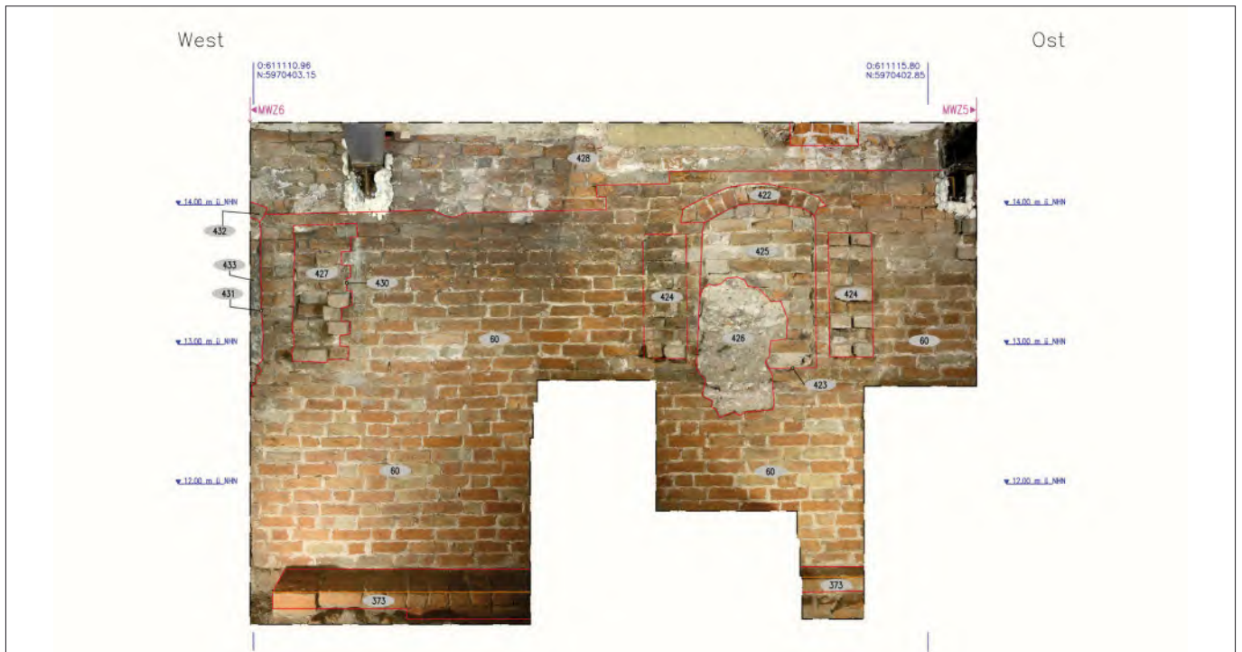
Abb. 6 Die Südwand des Kellers, Blick vom Süden.
