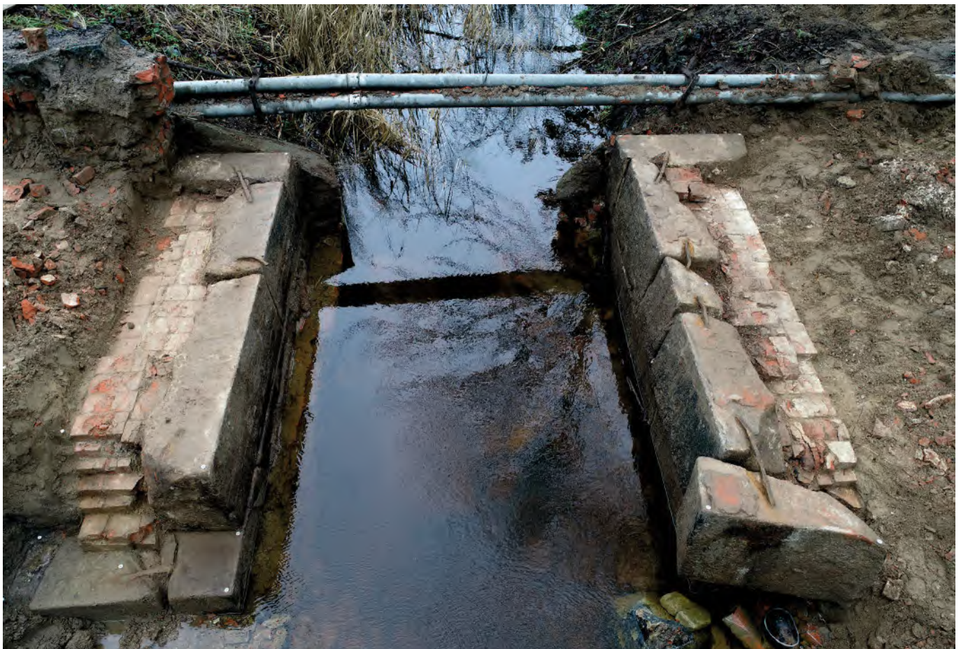
Abb. 6 Gem. Strecknitz, Fdst. 5.27.60. Die beiden Widerlager der Brücke der Phase 1.
