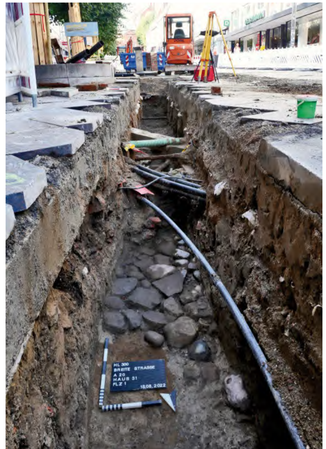
Abb. 5 Befestigung der Oberfläche mit Natursteinen im Gehwegbereich vor Haus 31.
