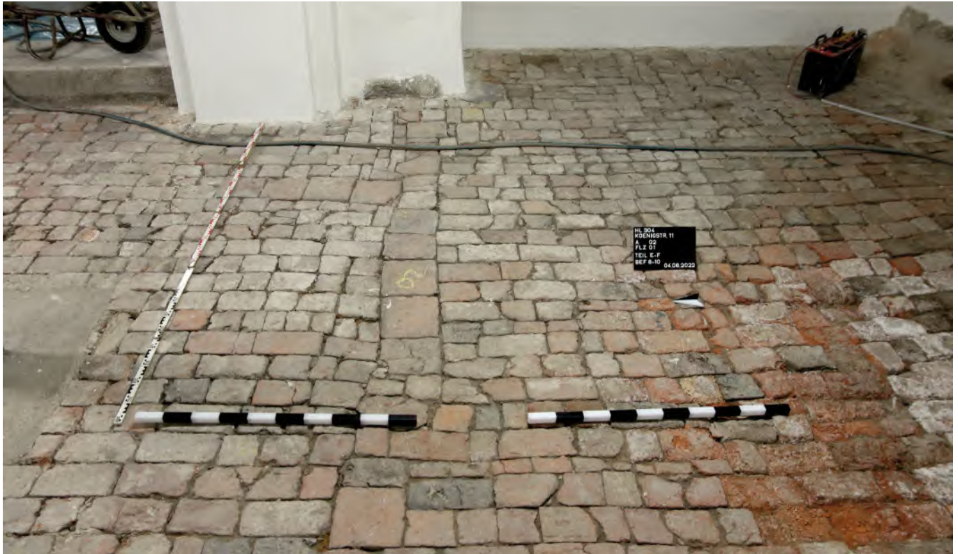
Abb. 10 Der jüngste Backsteinfußboden im Vorderhauskeller.
